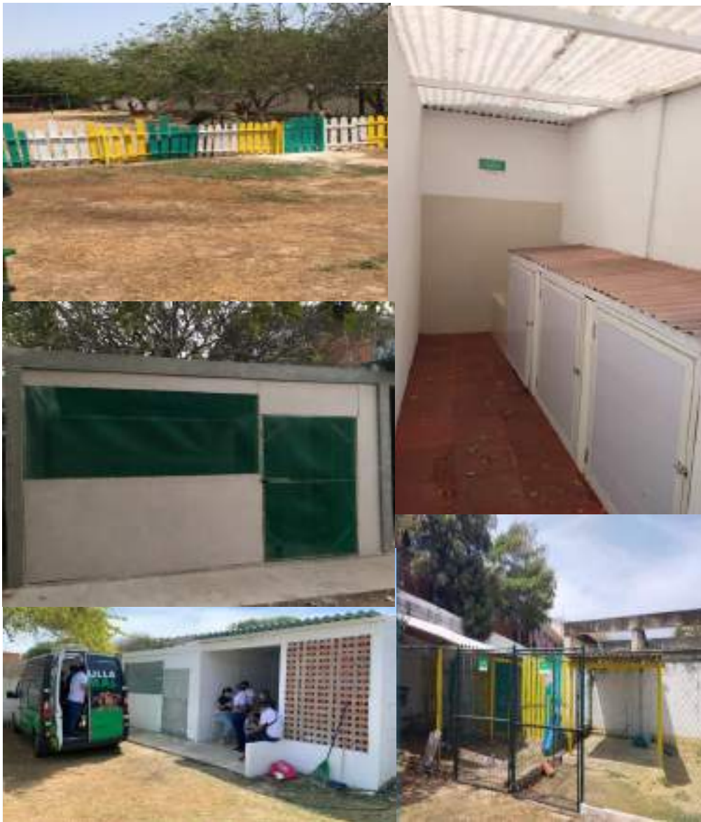
Imagen 49. Adecuaciones planta física
